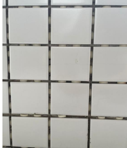
Figura 28 – Espaçamento entre as placas cerâmicas.
