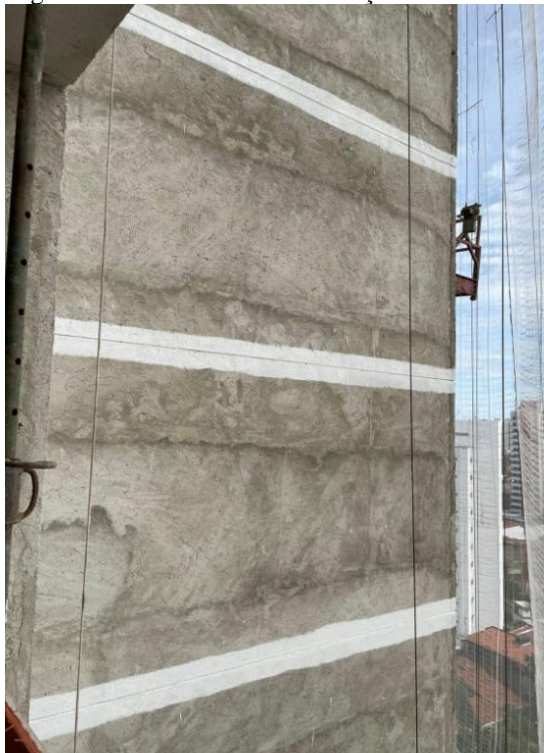
Figura 32 – Juntas de movimentações horizontais.
