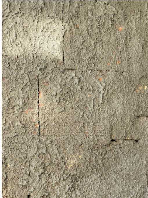
Figura 5 – Chapisco na fachada.
