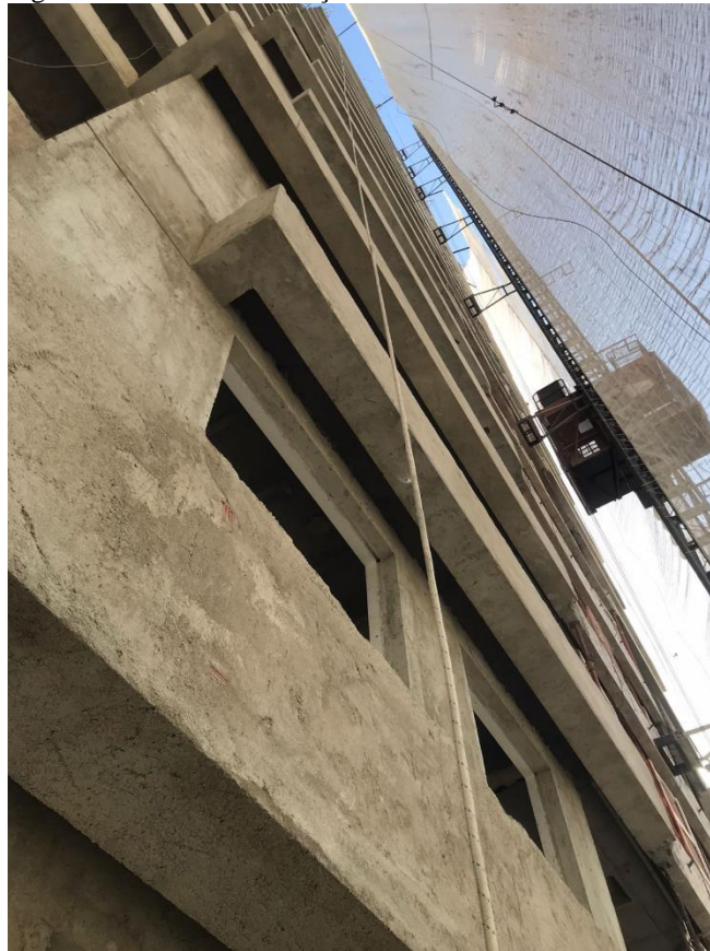
Figura 23 – Fachada emboçada.
