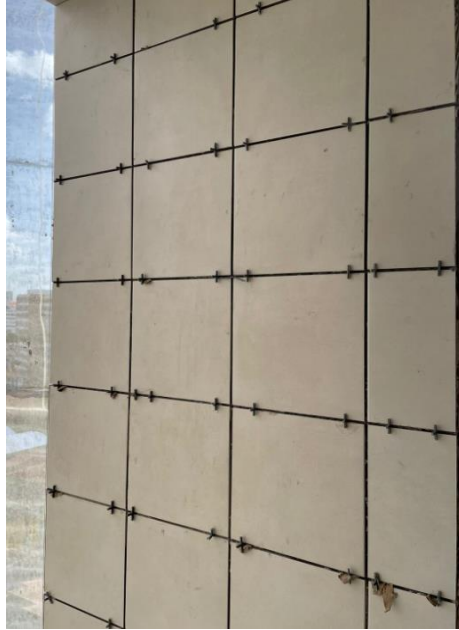
Figura 26 – Espaçadores na peça cerâmica.
