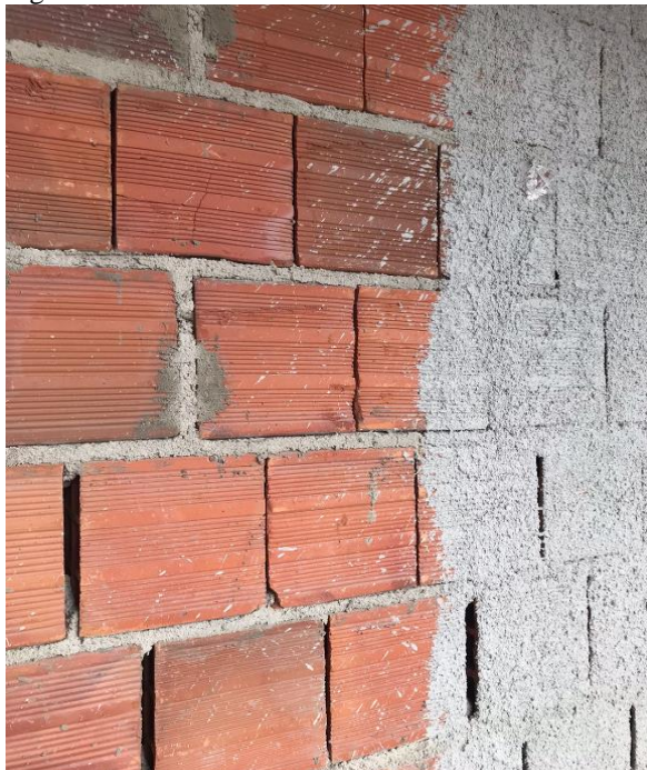
Figura 4 – Base de alvenaria na fachada.
