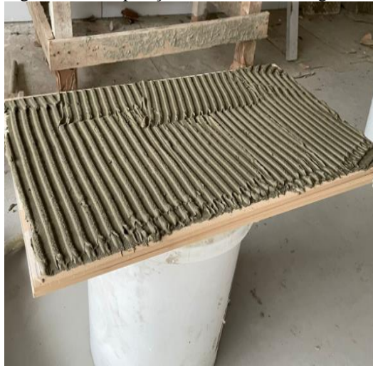
Figura 25 – Disposição dos cordões da argamassa colante.
