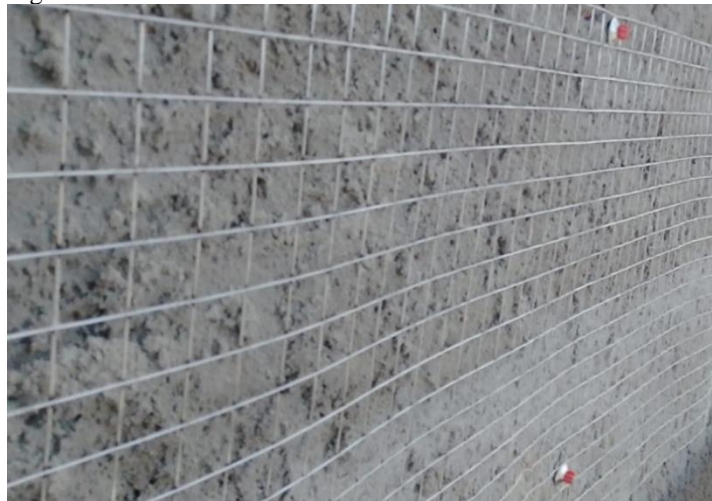
Figura 24 – Tela metálica na fachada.
