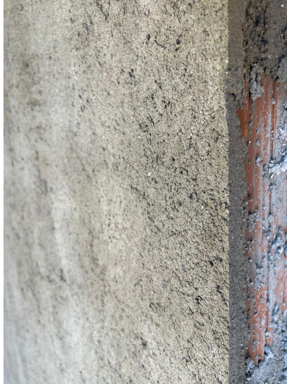
Figura 6 – Emboço na fachada.
