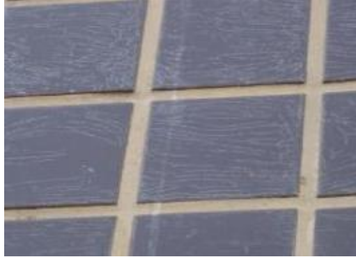
Figura 13 – Gretamentos nas superfícies das cerâmicas.
