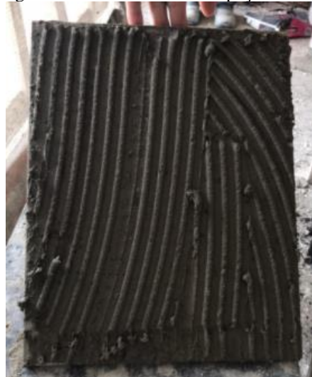
Figura 10 – Assentamento de peça cerâmica.
