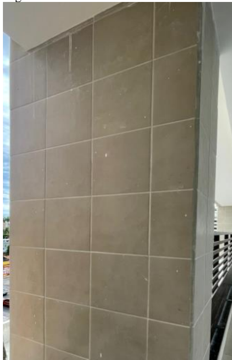
Figura 27 – Acabamento final das cerâmicas.
