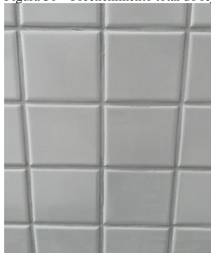
Figura 30 – Preenchimento total do rejunte.
