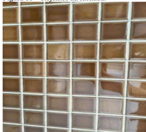
Figura 11 – Rejuntas na fachada.
