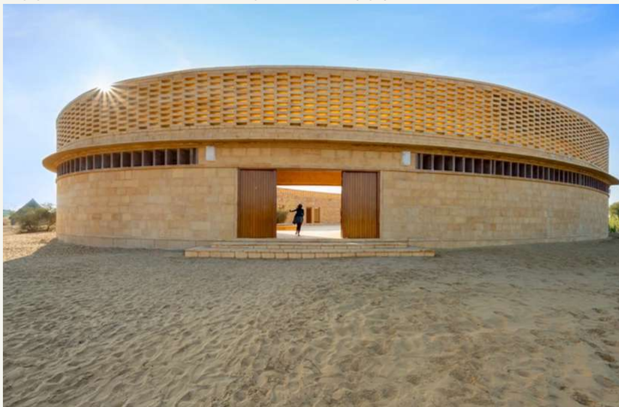
FIGURA 7 – ENTRADA PRINCIPAL DA ESCOLA
