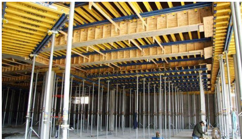
Figura 17 – Fôrmas para concreto: características e execução
