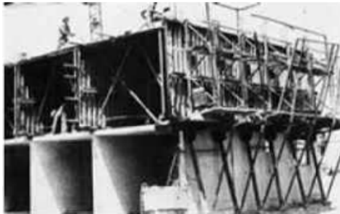
Figura 4 – Fôrma em formato de túnel – Outinord
