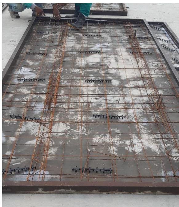
Figura 7 – Fôrma de laje pré-fabricada
