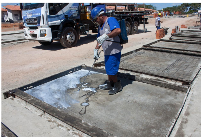
Figura 31 – Aplicação de desmoldante na pista.
