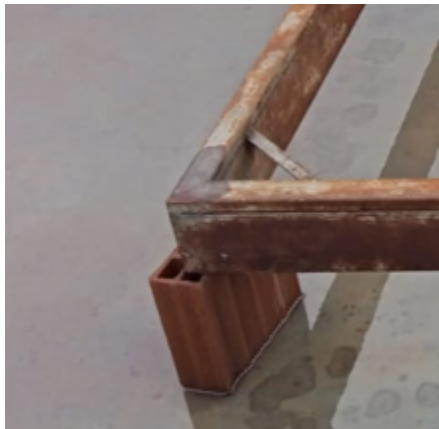
Figura 30 – Soldas em fôrmas.
