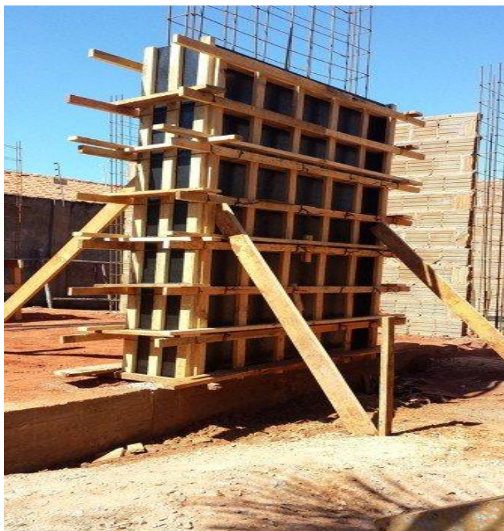
Figura 5 – Fôrma para confecção de pilar
