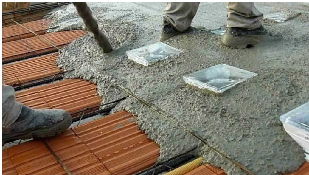
Figura 21 – Como fazer a concretagem da laje
