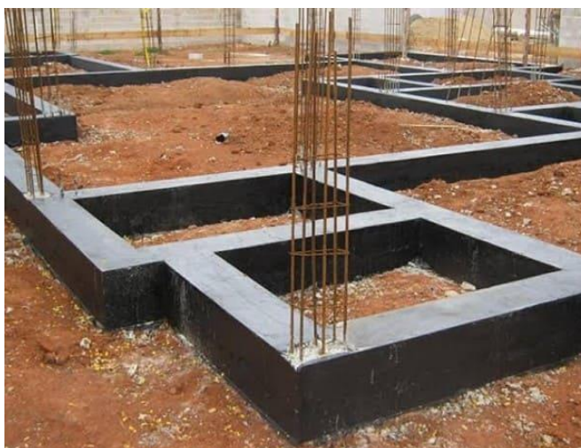
Figura 23 – Confeção de uma viga baldrame bem executada
