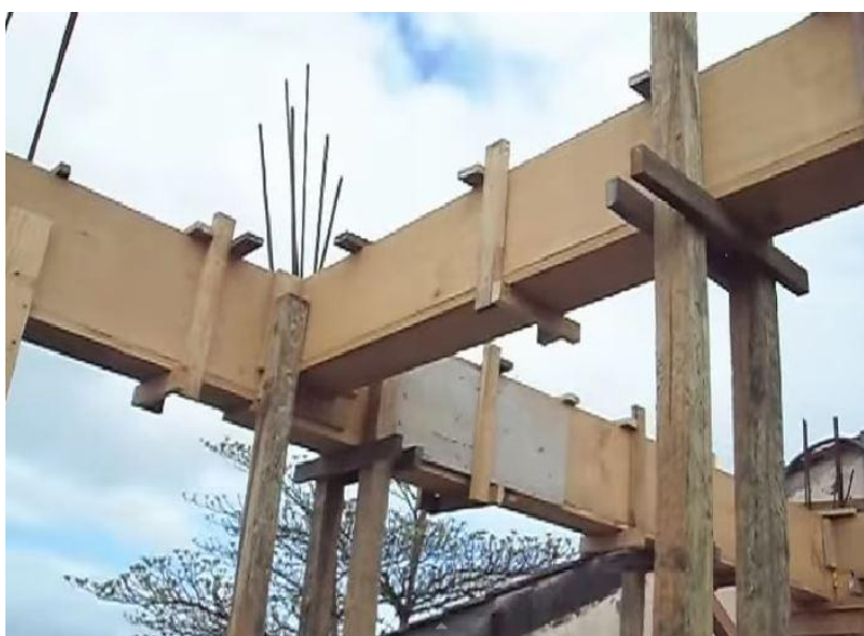
Figura 10 – Fôrma para vigas
