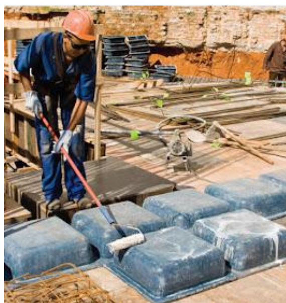
Figura 13 – Fôrma de PVC para laje nervurada
