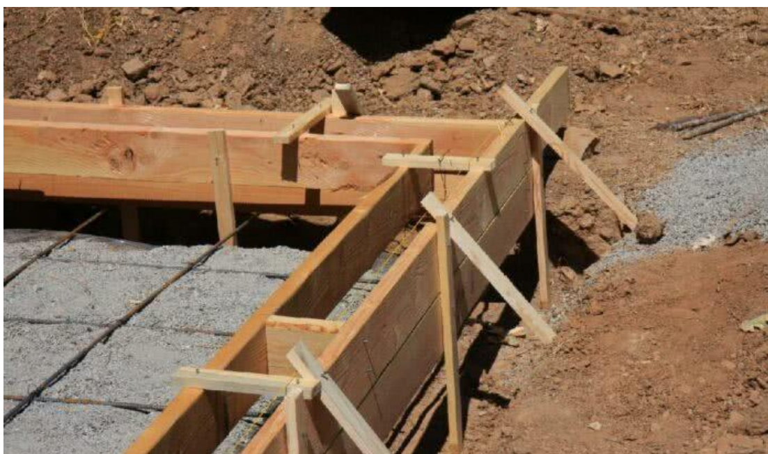
Figura 2 – Fôrma para viga-baldrame
