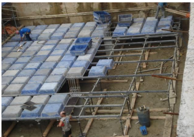
Figura 12 – Montagem de fôrma
