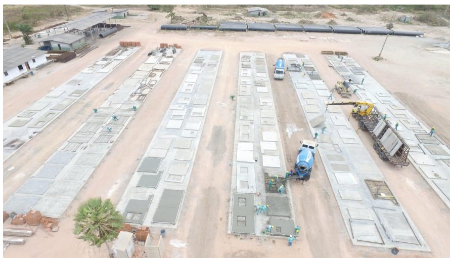
Figura 29 – Pista de concreto para fabricação de pré-fabricado.
