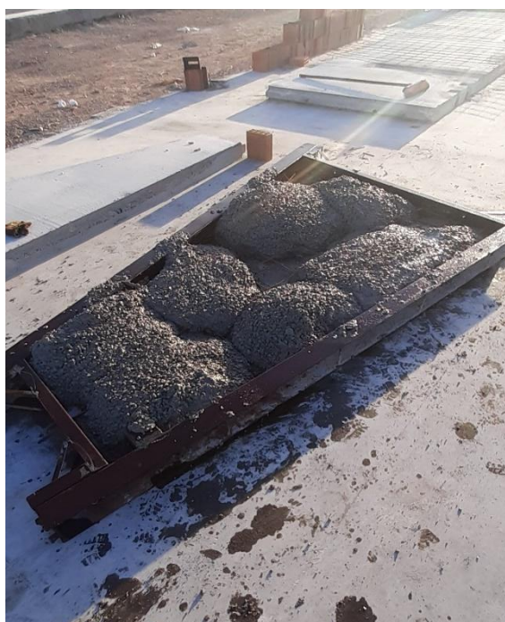
Figura 14 – Fôrma para confecção de uma empena pré-fabricada
