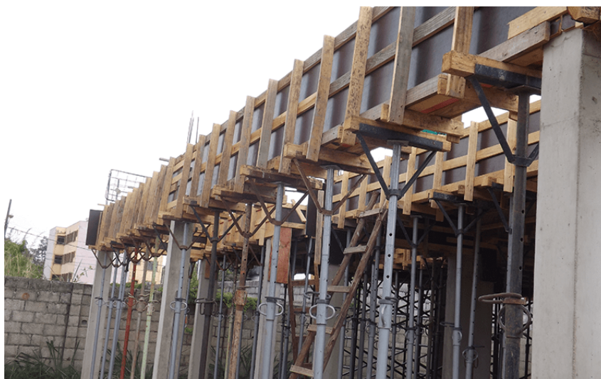
Figura 9 – Sistema de fôrma para viga
