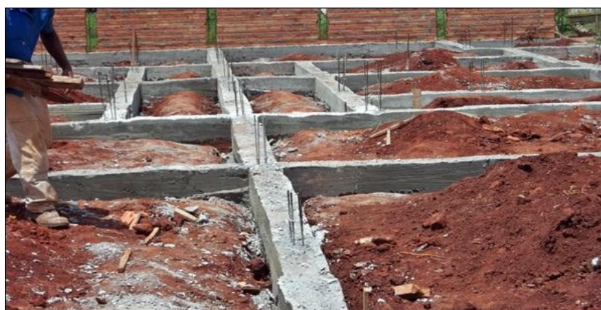
Figura 22 – Concretagem de uma viga baldrame
