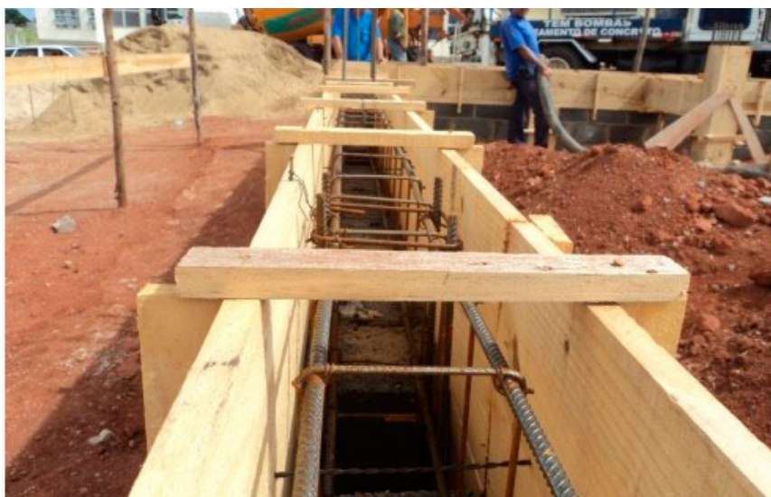
Figura 19 – Travamento de madeira
