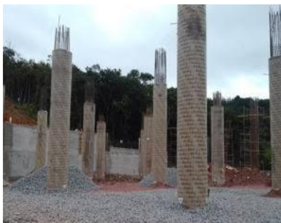
Figura 15 – Fôrma de papelão na confecção de pilares circulares
