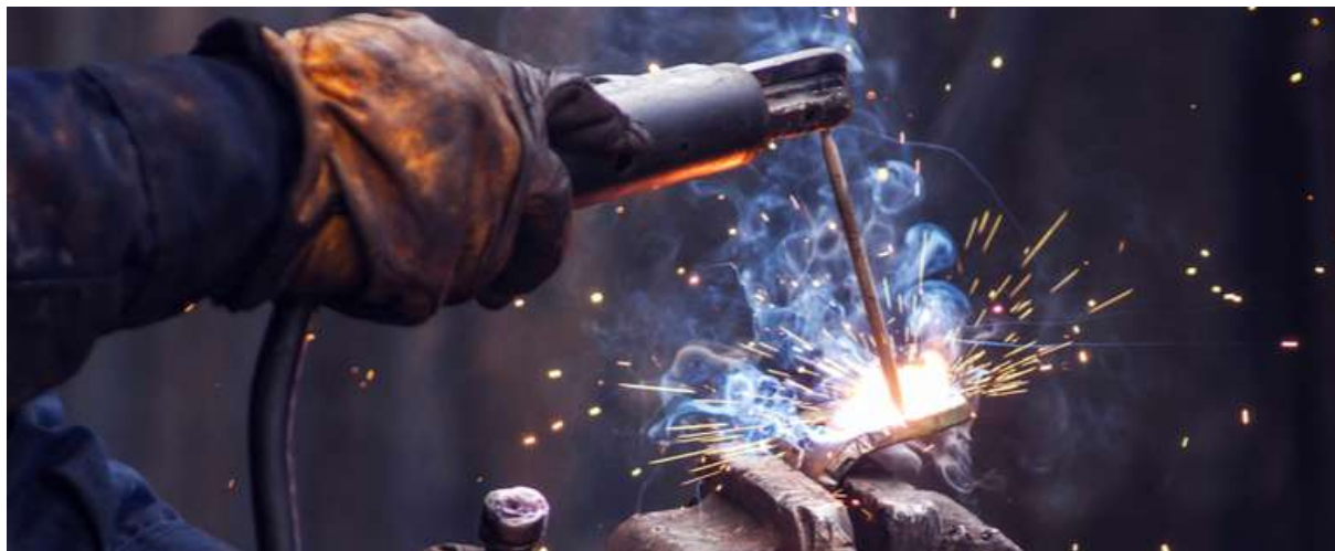
Legenda: Soldagem nas estruturas metálicas. Fonte: A Voz da Indústria, 2021.
