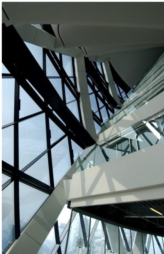
Figura 18 – Vista interna do átrio, Torre 30 St Mary Axe
