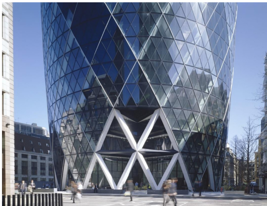
Torre 30 St Mary Axe Figura 17 - Entrada principal,
