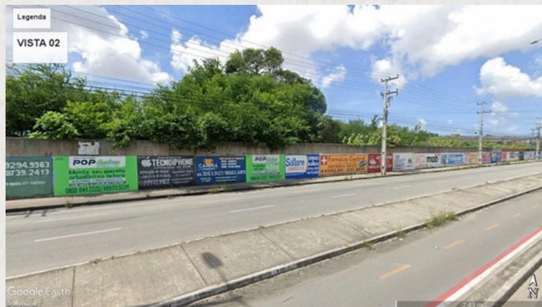
Figura 57: Vista 02 - Terreno de Intervenção
