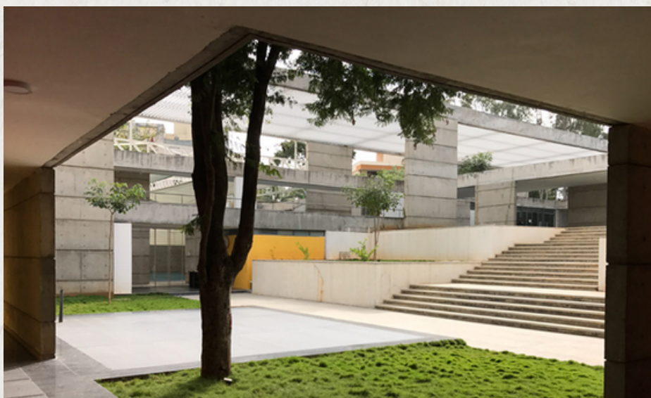
Figura 40: Estrutura em Concreto Armado
