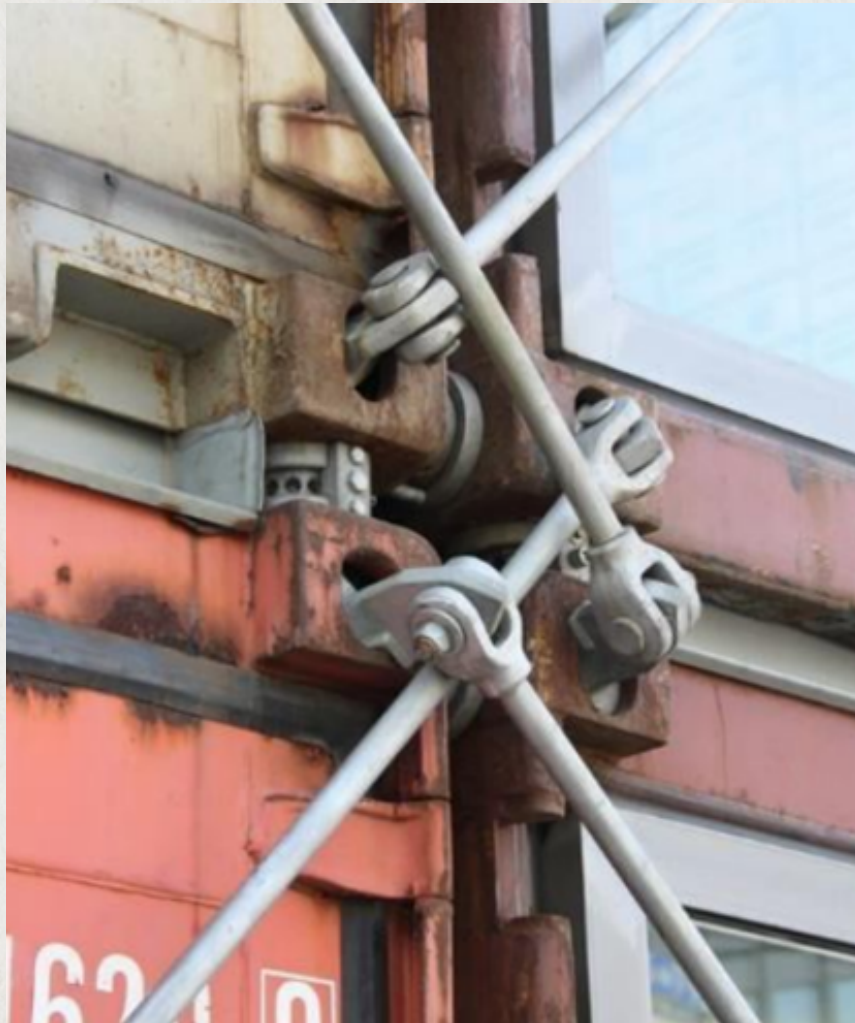
Figura 20: Ligação entre containers através de contraventamentos
