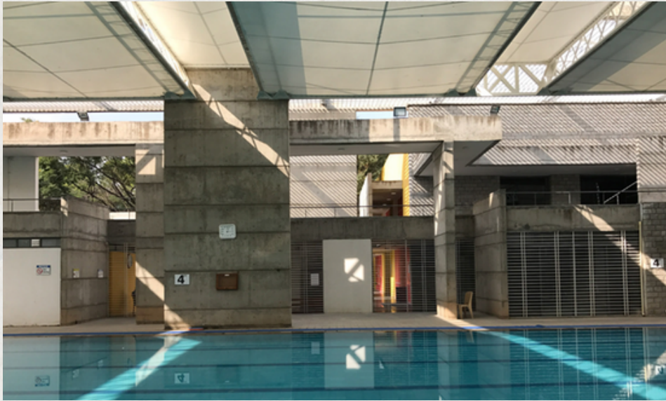
Figura 41: Coberta Metálica com Lona Tensionada
