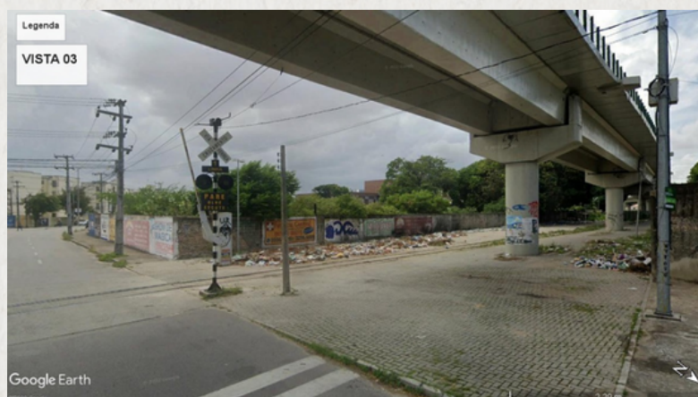
Figura 58: Vista 03 - Terreno de Intervenção
