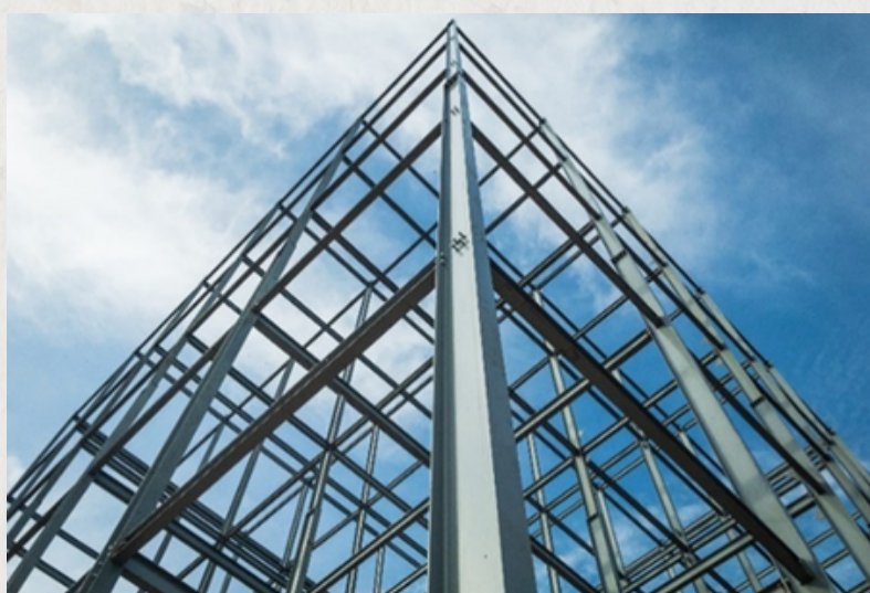
Figura 14: Construção de Estrutura em Aço
