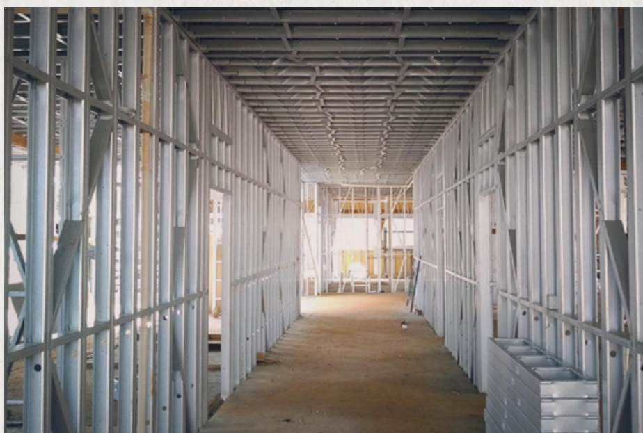
Figura 15: Construção de Estrutura em Aço com técnica Light Steel Framing
