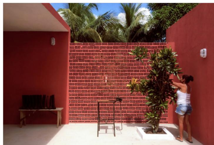
Figura 17: Elementos vazados na Sede Castanhas de Caju.
