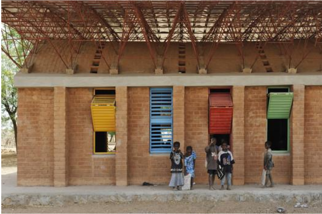
Figura 29 - Ampliação Escola Primária de Gando.
