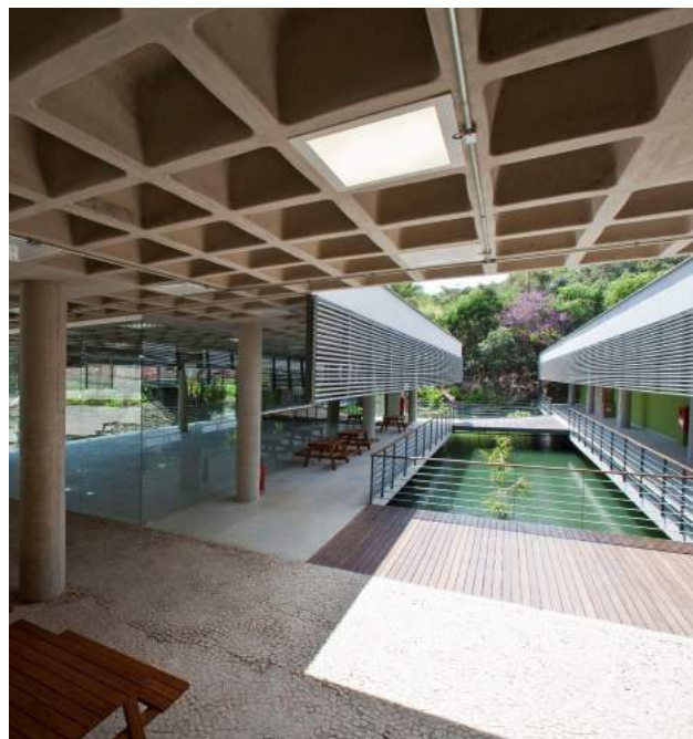
Figura 33 - Laje Nervurada. Fonte: Arquitetos Associados.
