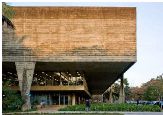
Figura 10 – Fachada da FAU-USP. Fonte: Nelson Kon 2011.
