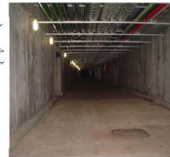
Figura 75 d - Vista interna das galerias.
