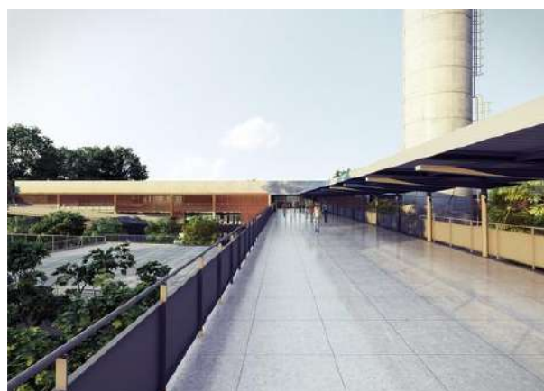
Figura 23 - Fachada localizada no maior nível
