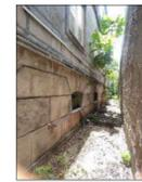
REMOÇÃO DO ELEMENTO NÃO ORIGINAL. RECONSTITUIÇÃO DA CANTARIA E REMOÇÃO DA CROSTA NEGRA ATRAVÉS DA LIMPEZA MECÂNICA.
