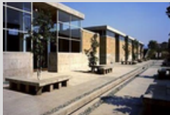
Figura 26: Praça central. Fonte: (ARCHDAILY, 2011).
