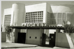
Figura 39: Fachada do Jockey Club Cearense em 1947. Fonte: Fortaleza em fotos.
