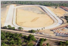
Figura 40: Instalações do Jockey Club Cearense em 1947. Fonte: Fortaleza em fotos.
