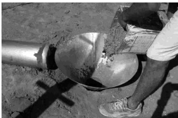
Figura 2.6 – Concretagem com funil em estacas escavadas
