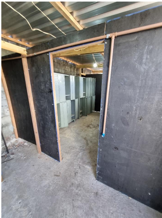
Figura 20 – Construção do vestiário.
