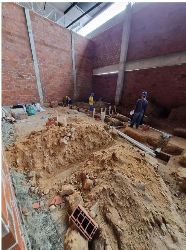
Figura 17 – Caixas de inspeção 60x60cm.
