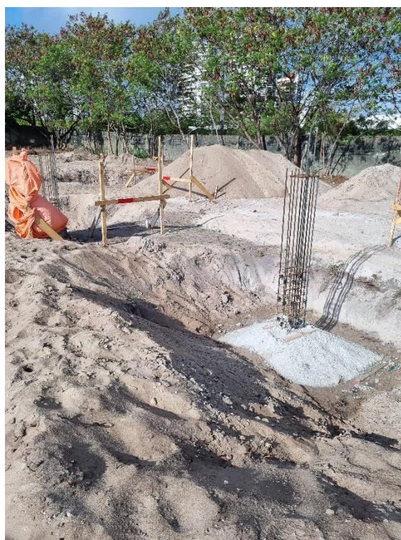
Figura 32 – Fundação tipo sapata.
