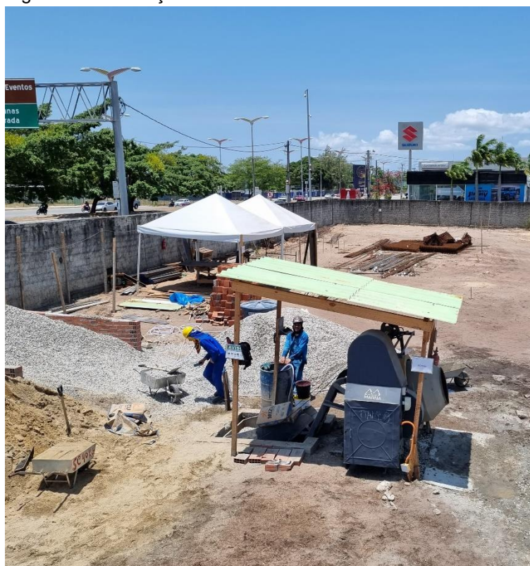
Figura 24 – Produção de concreto.
