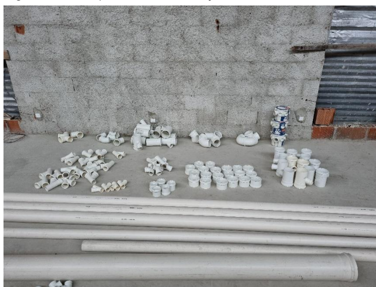
Figura 29 – Desperdício de instalações.
