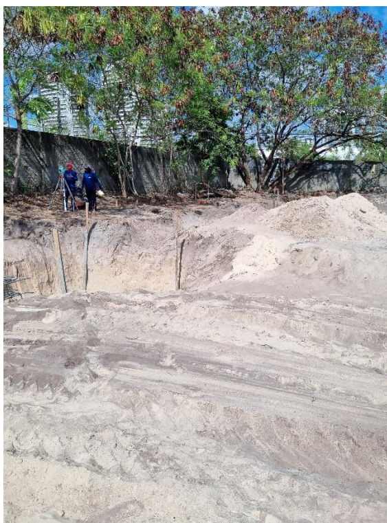
Figura 33 – Locação das fundações.
