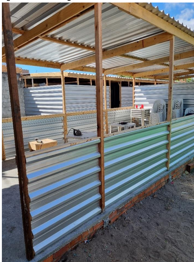
Figura 21 – Montagem do refeitório.
