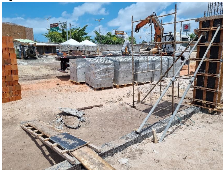
Figura 34 – Bloco de concreto.
