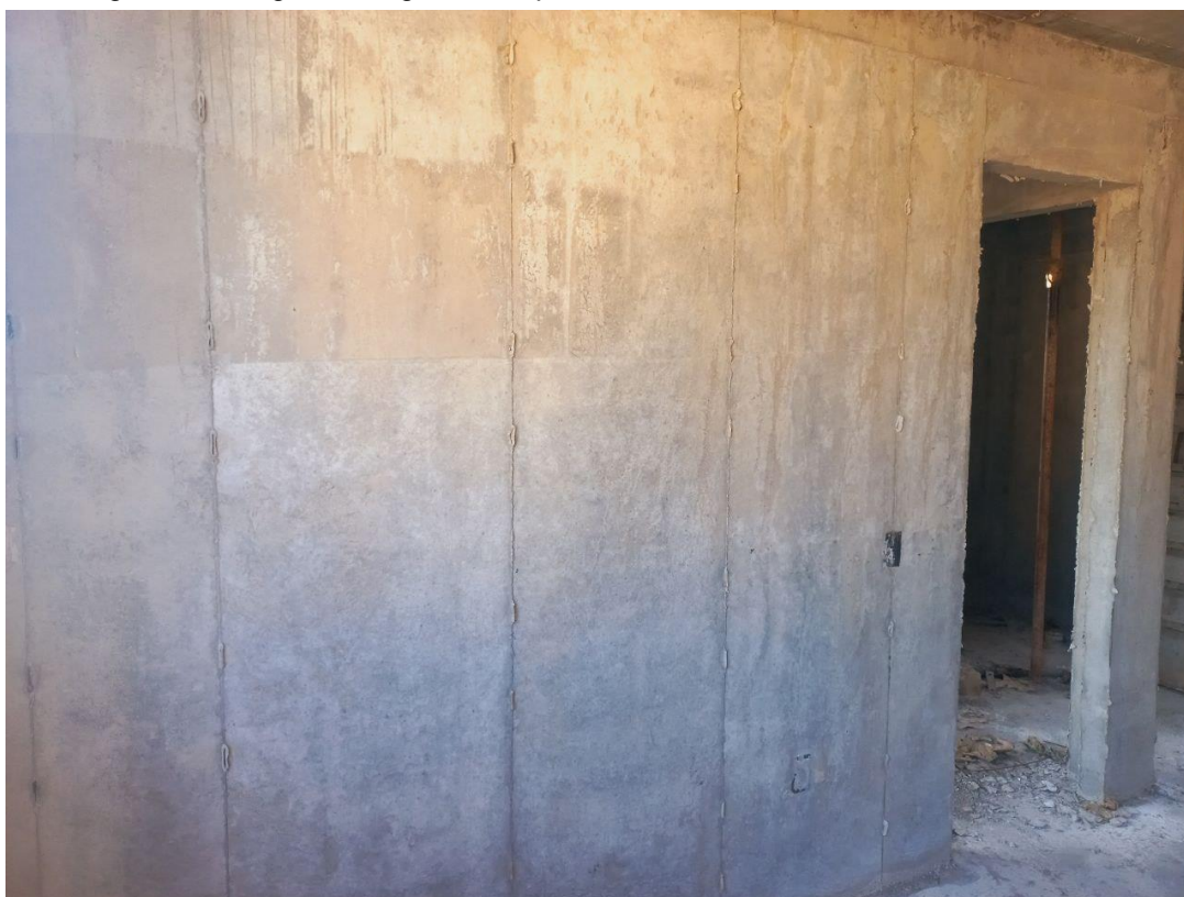
Figura 61 - Registro fotográfico da parede de concreto autoadensável – Usina B
