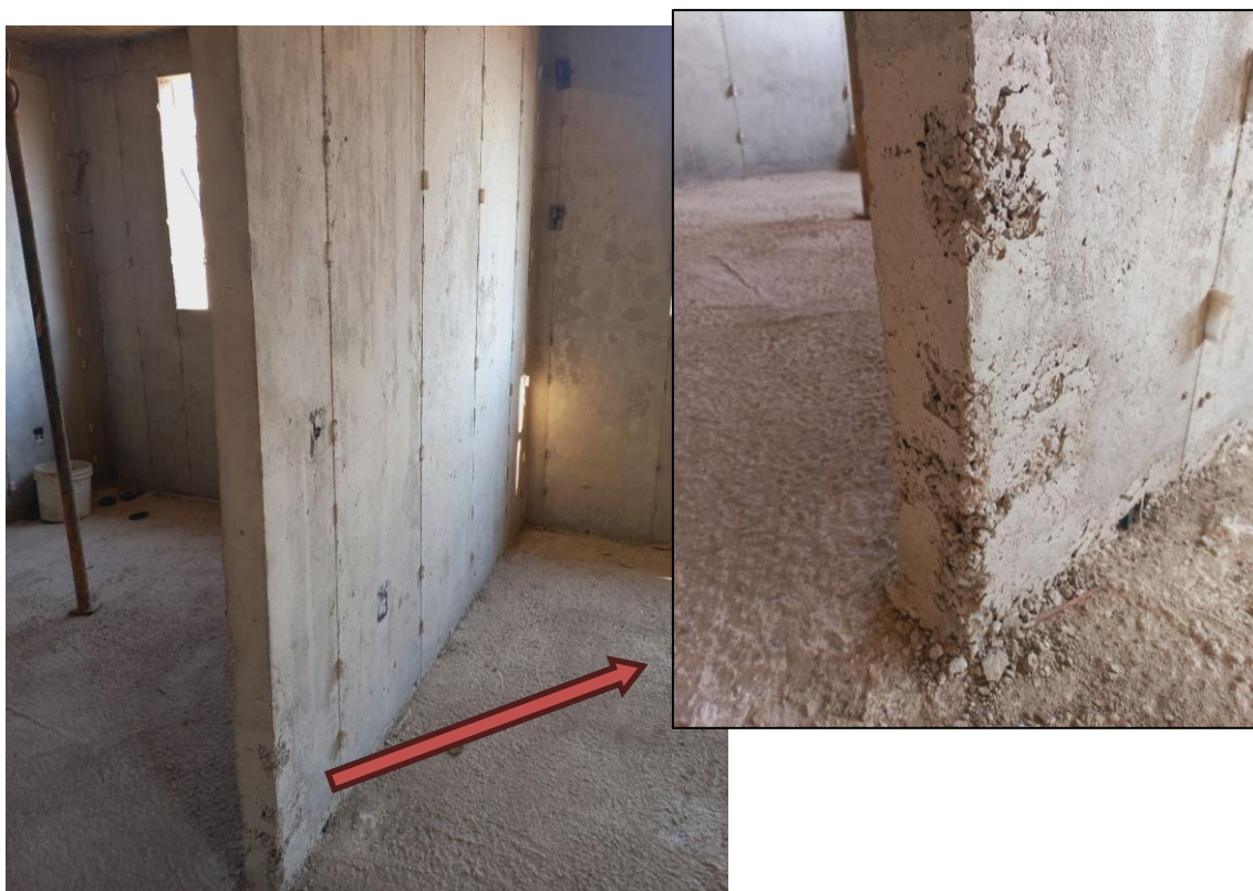
Figura 65 - Registro fotográfico da parede de concreto superfluido com nicho de concretagem – Usina B
