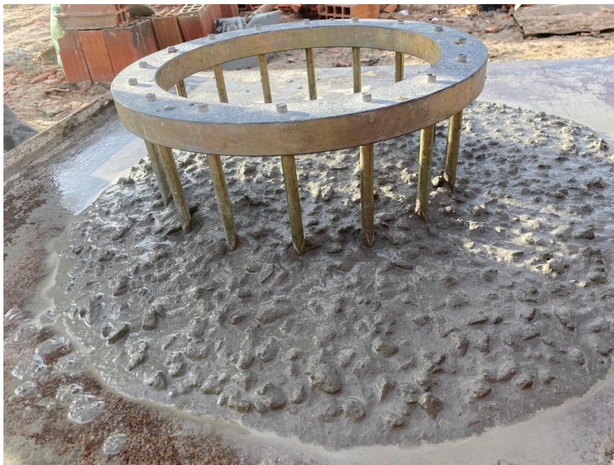
Figura 30 - Realização de ensaio de caracterização (anel J) antes do lançamento do concreto (1º dia).
