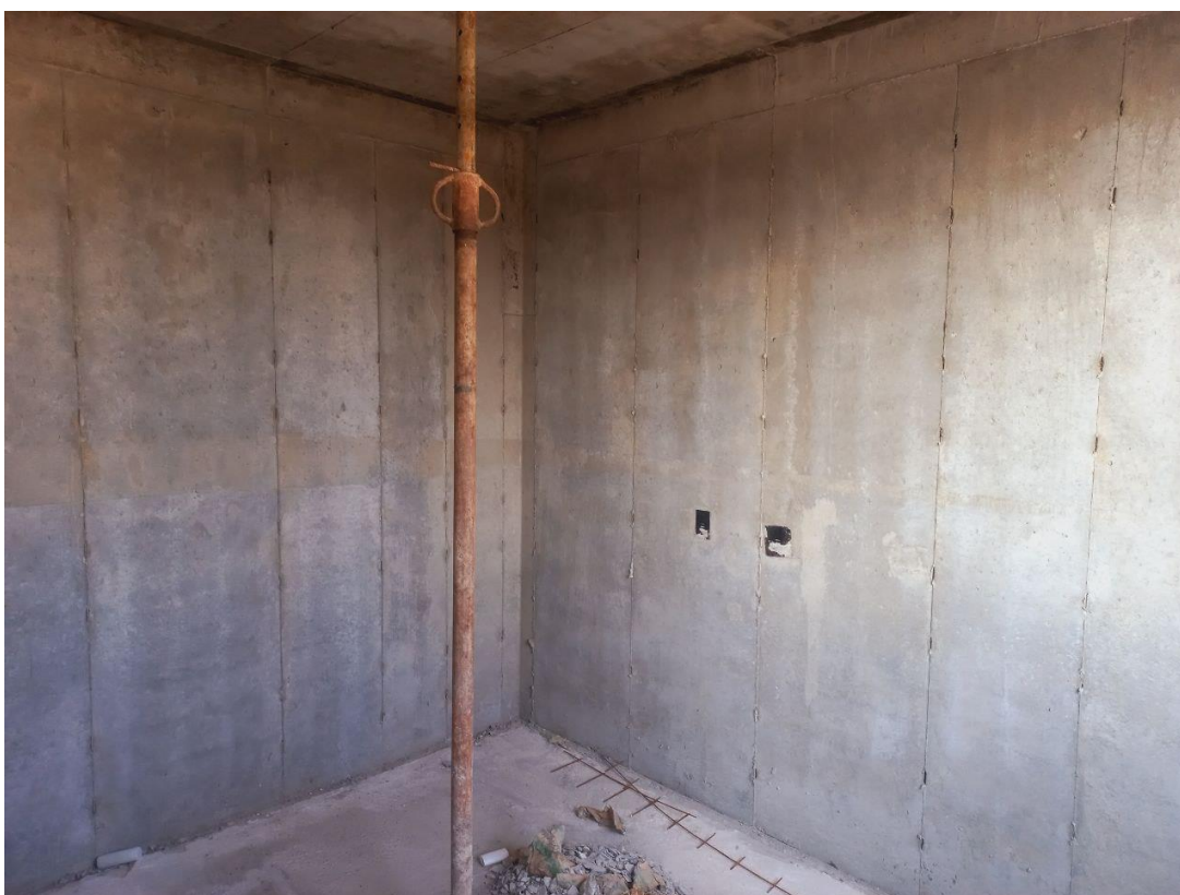
Figura 60 - Registro fotográfico da parede de concreto autoadensável – Usina B
