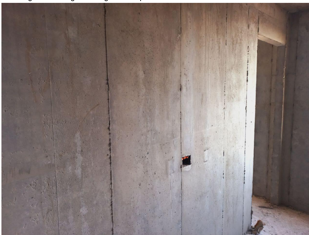
Figura 62 - Registro fotográfico da parede de concreto autoadensável – Usina B
