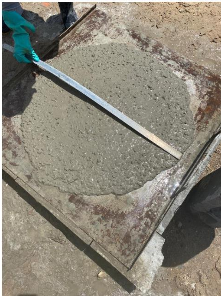
Figura 32 – Realização de ensaio de caracterização antes do lançamento do concreto (2º dia).
