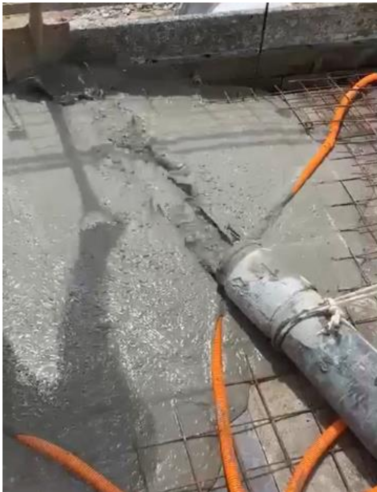
Figura 33 - Lançamento do concreto nas fôrmas das paredes
