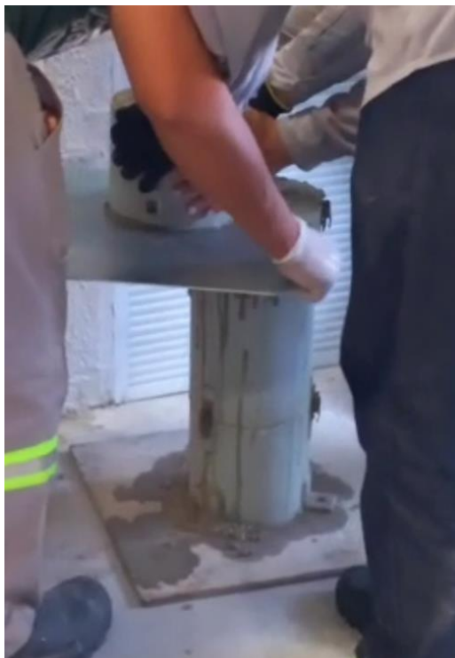
Figura 23 - Execução da retirada da porção de concreto da coluna de segregação
