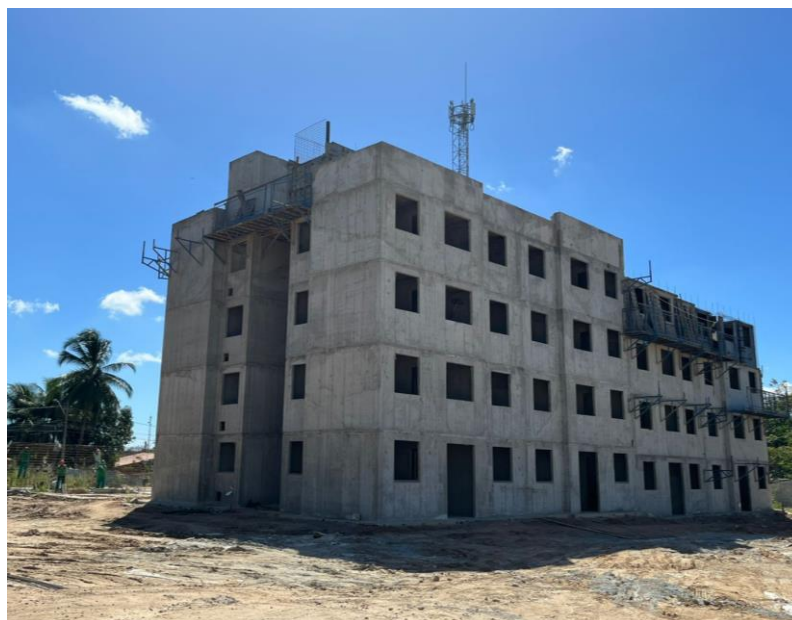
Figura 27 – Bloco 1 da Obra A, construído no sistema parede de concreto.
