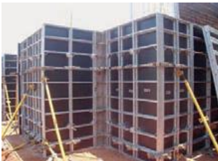
Figura 5 - Fôrmas metálicas com madeira compensada
