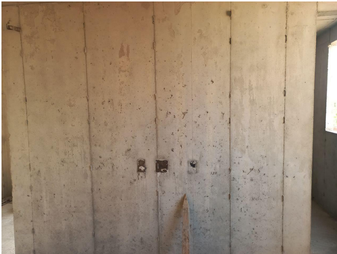
Figura 63 - Registro fotográfico da parede de concreto superfluido – Usina B
