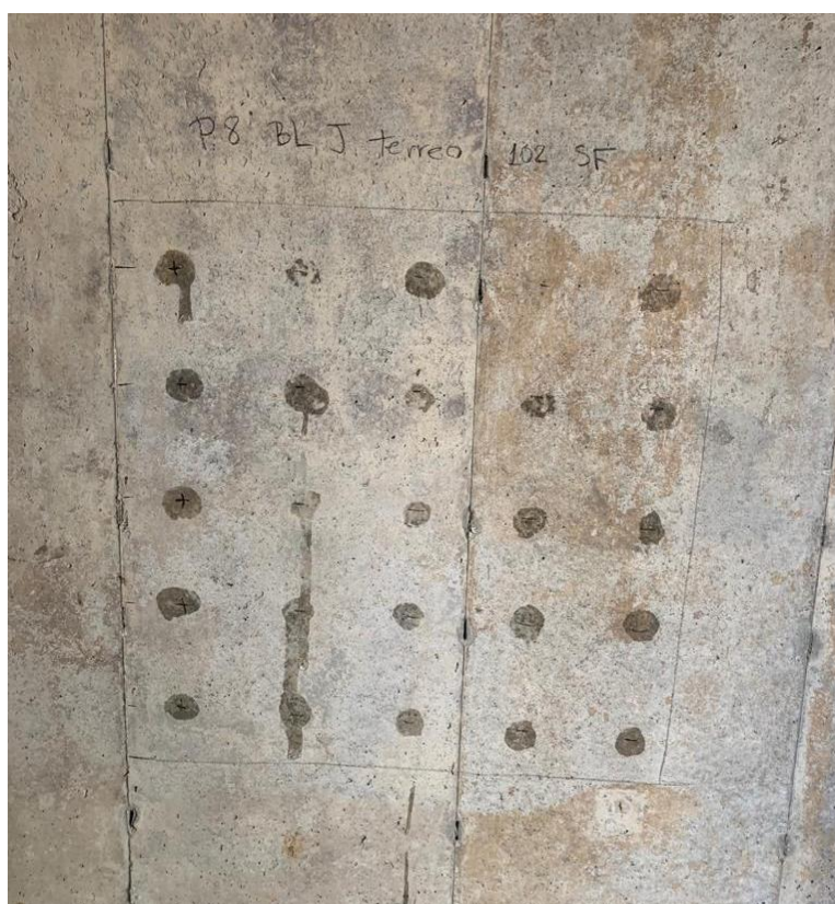
Figura 59 – Registro fotográfico da parede P8 – concreto superfluido – Usina A.
