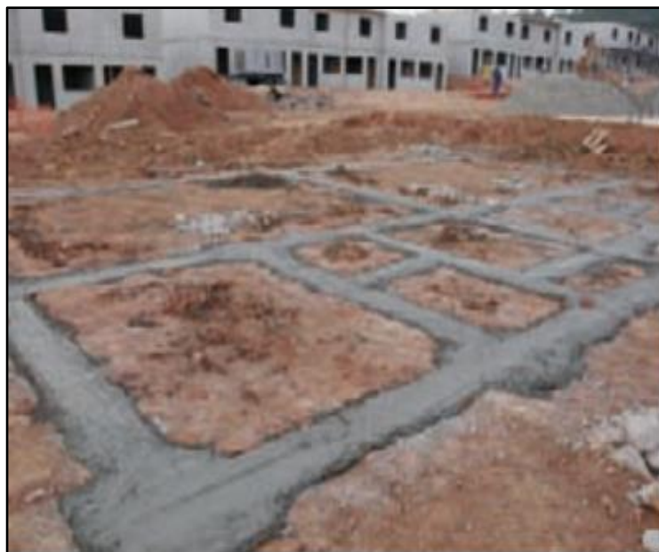
Figura 2 - Fundação do tipo sapata corrida
