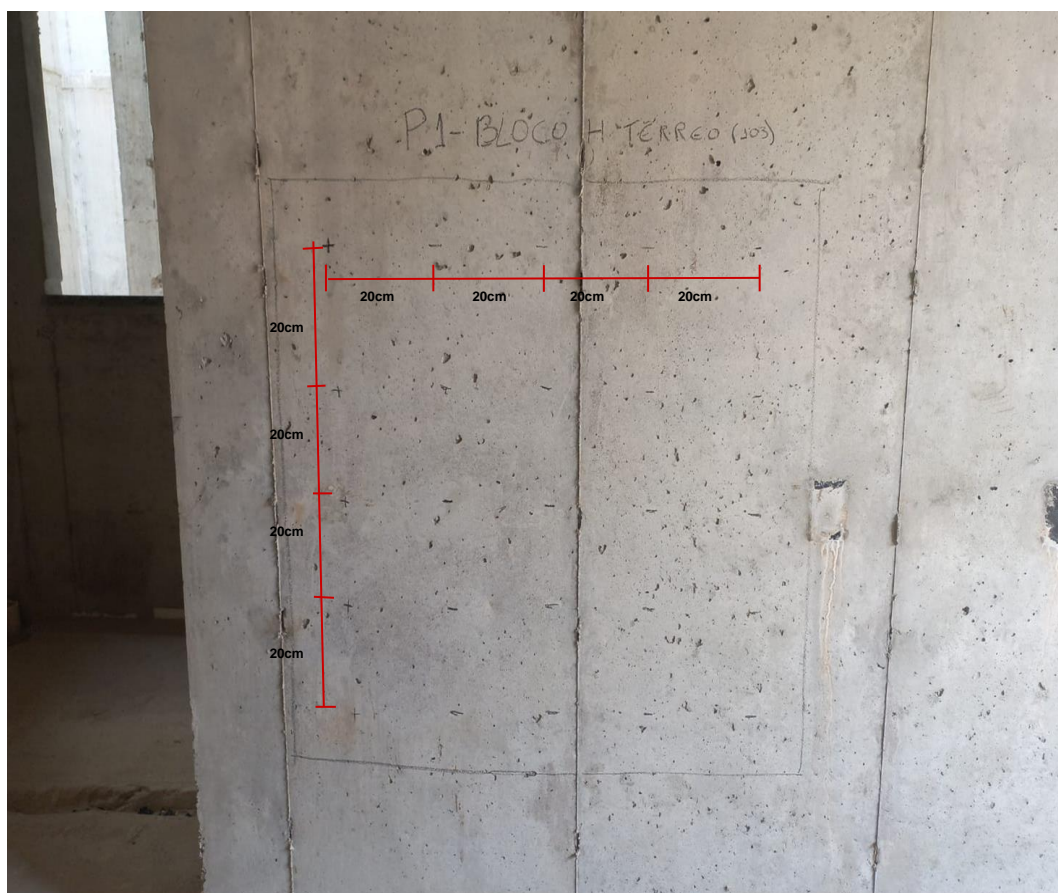
Figura 37 – Pontos na parede de concreto, utilizados para o ensaio.
