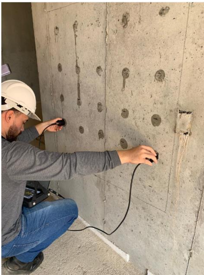
Figura 39 – Realização do ensaio de ultrassom por transmissão indireta, na parede de concreto.
