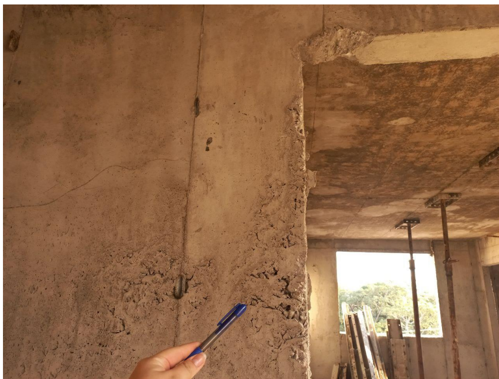
Figura 64 - Registro fotográfico da parede de concreto superfluido com nicho de concretagem – Usina B
