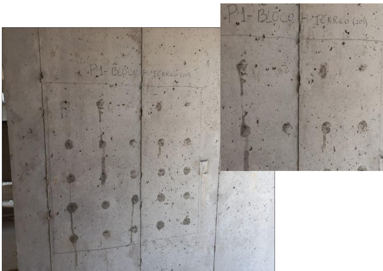
Figura 53 - Registro fotográfico da parede P1 – concreto superfluido – Usina A.
