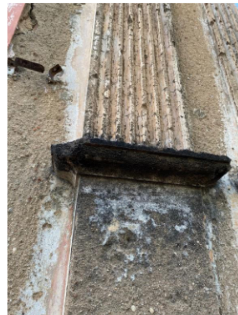
Figura 55 - Detalhes frisos das colunas na fachada sul
