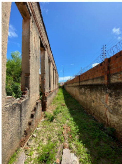
Figura 44 - Vista da fachada sul mostrando as janelas e detalhes do balaústre
