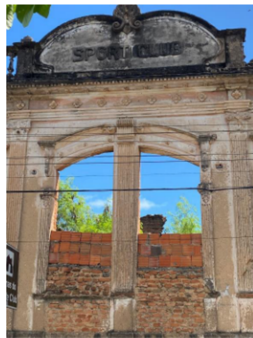
Figura 47 - Detalhes platibanda na fachada sul da edificação
