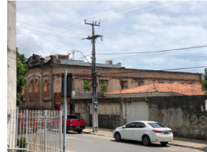
Figura 57 - Vista afastada do predio
