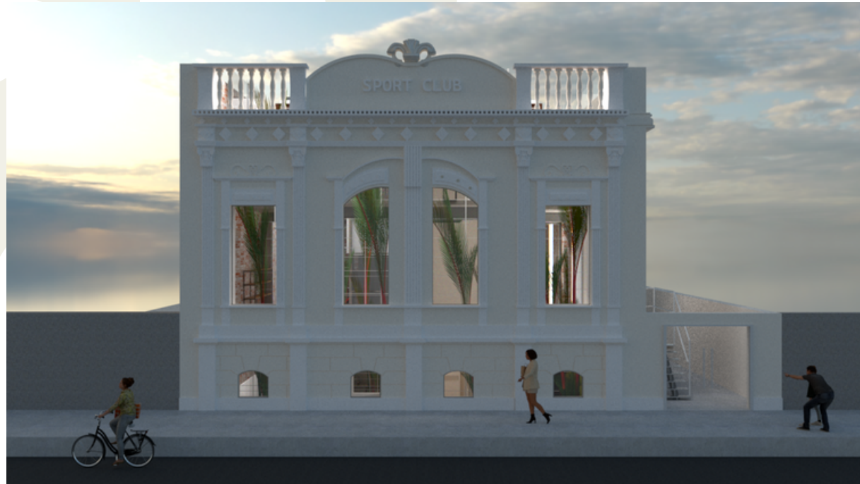
FACHADA PRINCIPAL FONTE: IMAGEM PRODUZIDA PELO AUTOR
