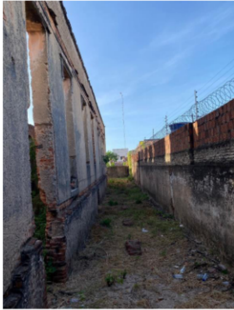
Figura 52 - Vista corredor lateral
