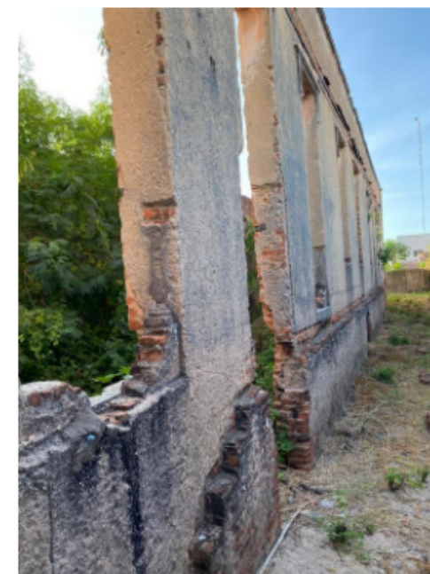
Figura 51 - Detalhes fachada leste da edificação
