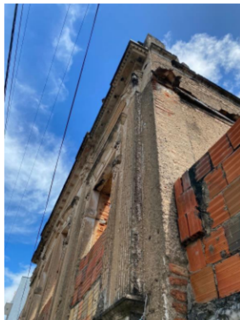
Figura 45 - Detalhes da fachada sul da edificação
