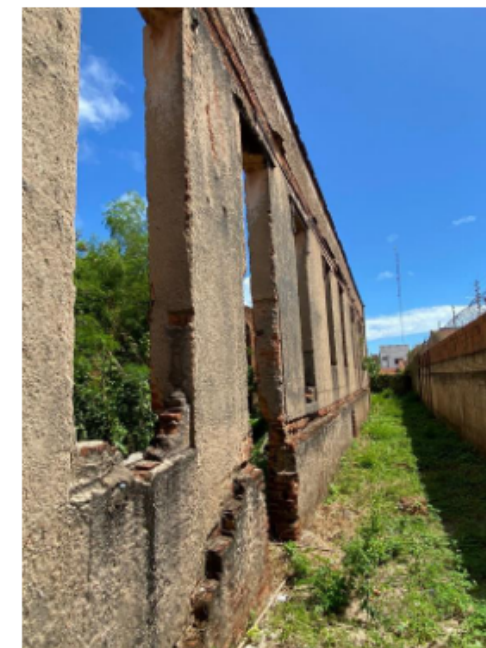
Figura 42 - Vista da fachada leste da edificação e com marcas de escada
