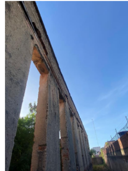
Figura 58 - Detalhes superiores na fachada leste da edificação
