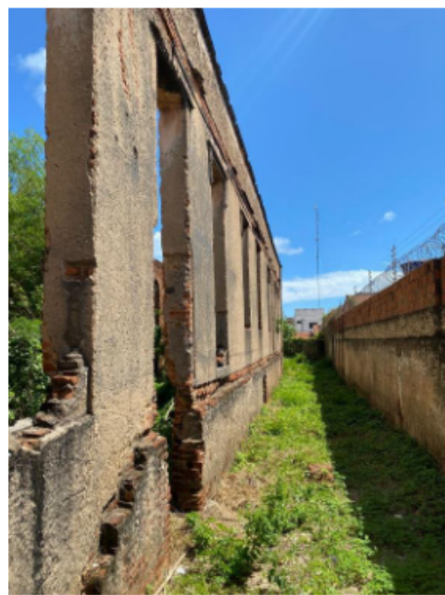
Figura 46 - Detalhe janelas na fachada leste da edificação
