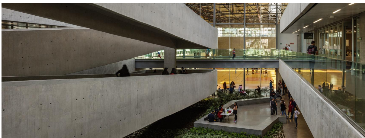
Figura 33- Acesso através de rampas- SESC Guarulhos
