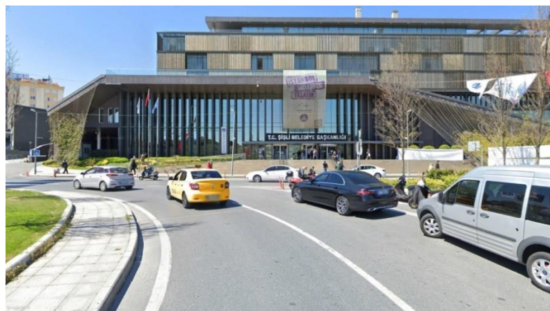
Figura 20- Vista da fachada principal do edifício- Prefeitura Şişli
