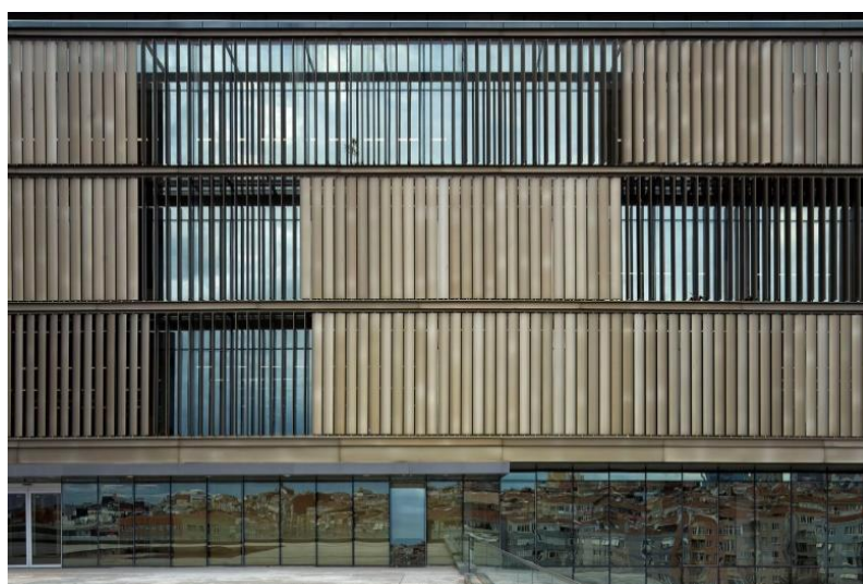
Figura 22- Sistema de brises móveis da fachada- Prefeitura Şişli
