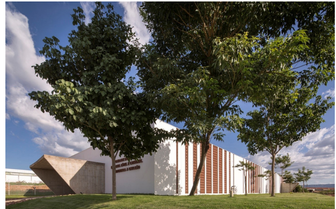
Figura 20: Acesso principal com pórtico em concreto Fonte: Lins Arquitetos Associados
