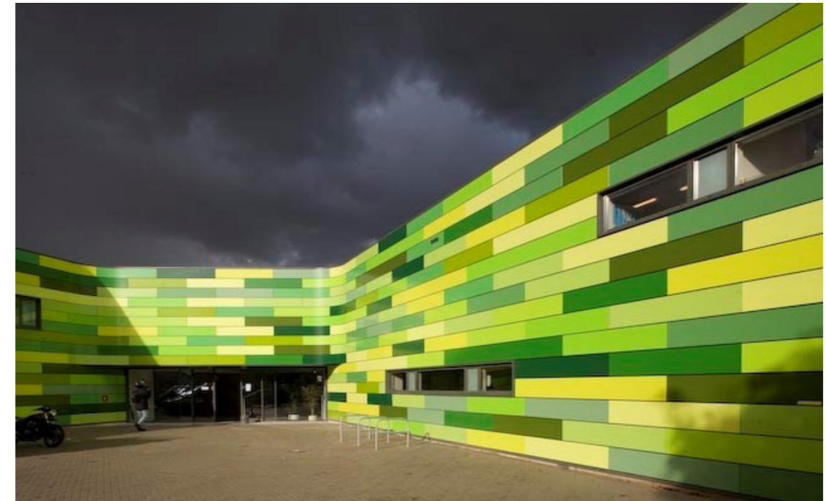
Figura 28: Acesso principal e revestimento da fachada Fonte: Archdaily (2012)
