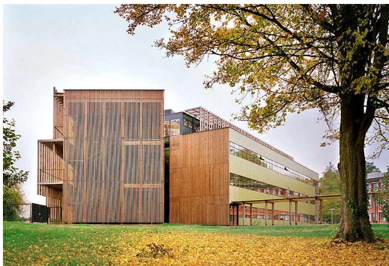
Figura 30: Fachada Norte do INRA.
