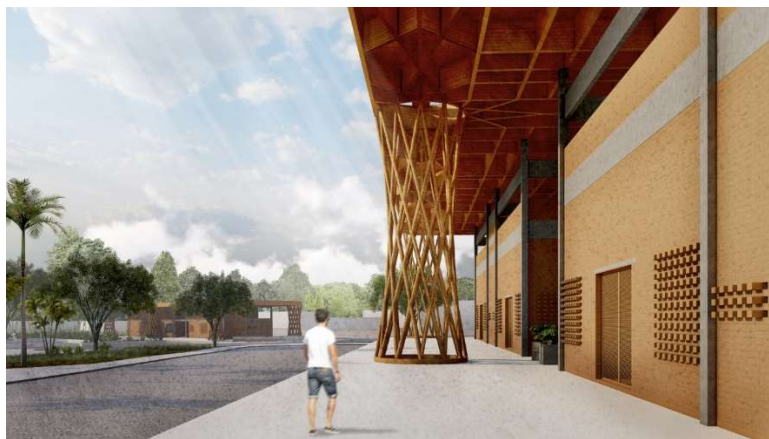
Figura 51: Pavilhão de Ensaios - Hiperboloide de uma folha
