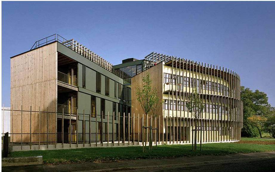
Figura 25: Fachada Oeste do INRA.
