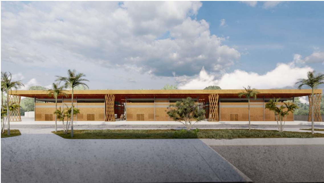
Figura 59: Pavilhão de Ensaios – Docas.
