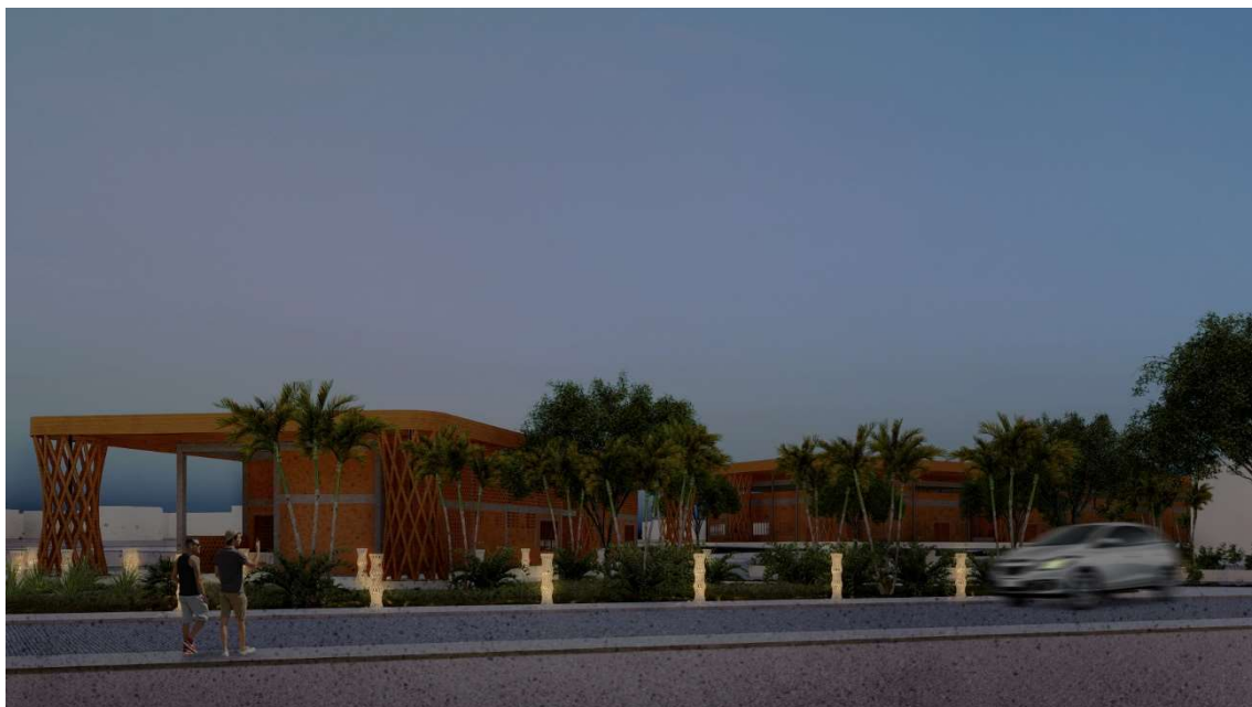
Figura 63: Pavilhão da Administração - Iluminação de piso.
