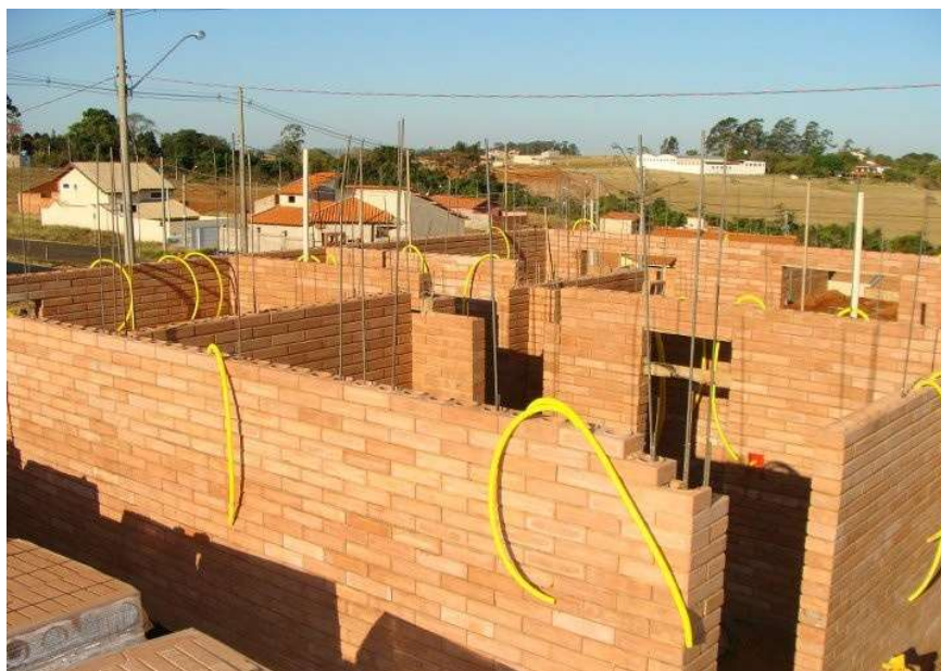
Figura 17: Instalações com o Tijolo Ecológico.
