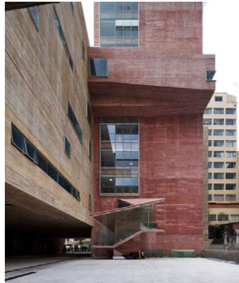
Figura 22 Bloco de concreto pigmentado em contraste com o restante da edificação fonte: Archdaily
