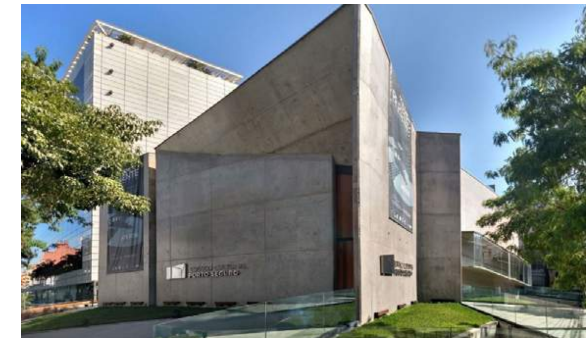
Figura 24 Vista da fachada principal e seu acesso fonte: Archdaily
