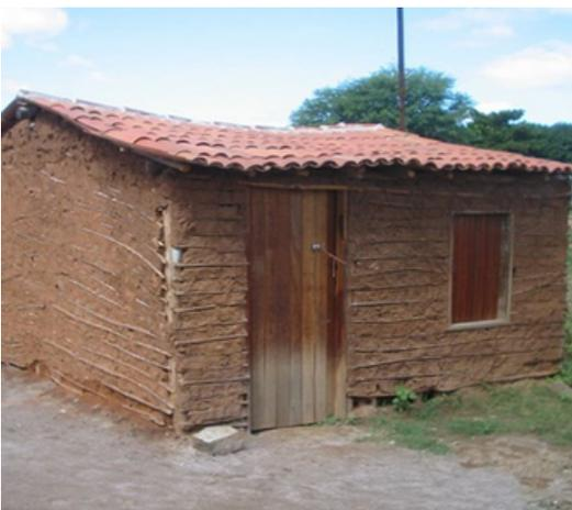
Figura 07: Casa construída na técnica construtiva de Pau a pique. Fonte: Ecoficientes
