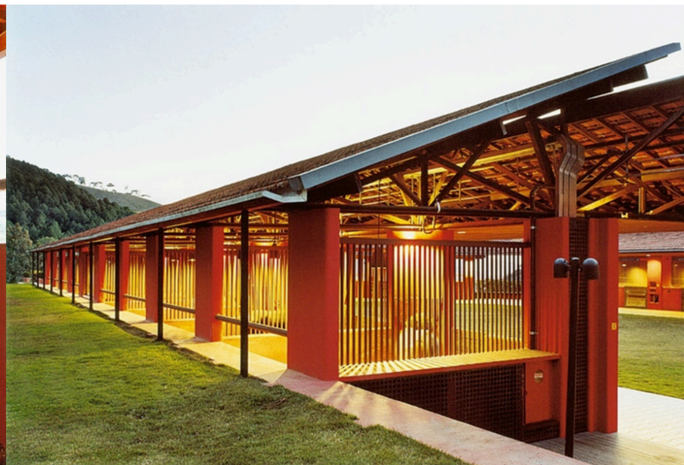
Figura 31 – Barras em aço corten./ Fonte: Nelson Kon, 2017
