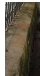
Musgos na base de alvenaria - Fachada Leste Internamente
