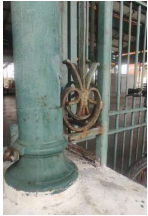
Oxidação em elemento de ornamentação da fachada oeste
