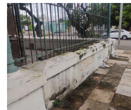
Descascamento na base - Fachada Leste
