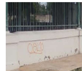
Descascamento na base - Fachada Oeste
