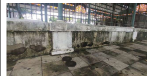
Descascamento na base - Fachada Leste
