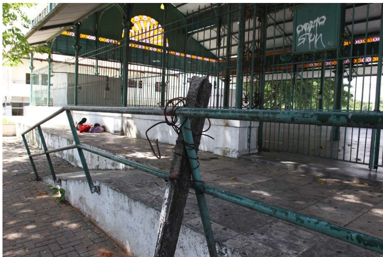
Figura 49 - Guarda corpo do Mercado seguro por um pedaço de concreto armado, e fios.
