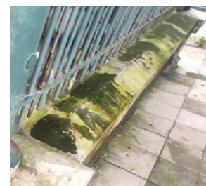
Musgos na base de alvenaria - Fachada Sul
