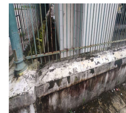
Descascamento na base - Fachada Sul
