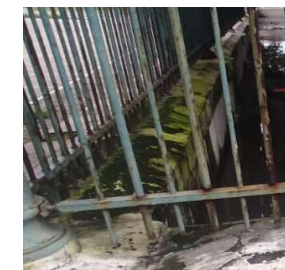
Musgos na base de alvenaria - Fachada Oeste Internamente
