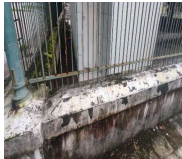
Oxidação nos gradis da fachada sul
