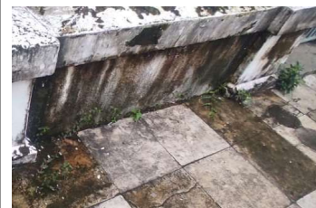
Vegetação nas bases de alvenaria.
