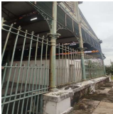
Oxidação nos pilares da fachada sul
