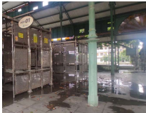
Oxidação nos pilares internos da edificação
