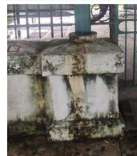
Musgos na base de alvenaria - Fachada Leste
