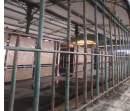
Oxidação nos gradis da fachada leste
