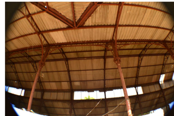
Figura 75 - Estrutura da cobertura do Mercado da Aerolândia antes do projeto de restauro de 2012.
