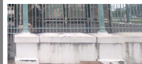
Descascamento na base - Fachada Norte
