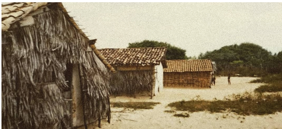
Figura 19: Edificações em taipa e palha na Vila de Jericoacoara Fonte: Acervo Jeri das Antigas. [1985].
