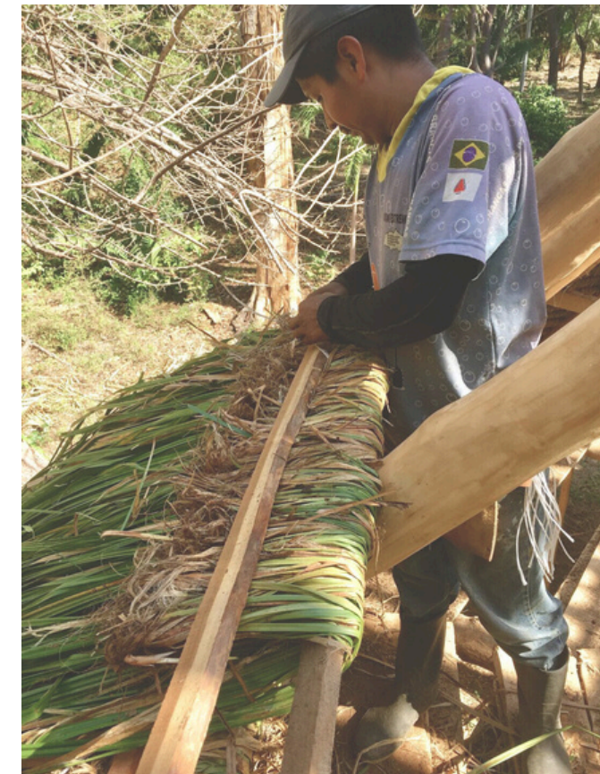
Figura 16. Processo de Produção da Esteira de Palha da Cobertura. Fonte: Archdaily Brasil, 2020.
