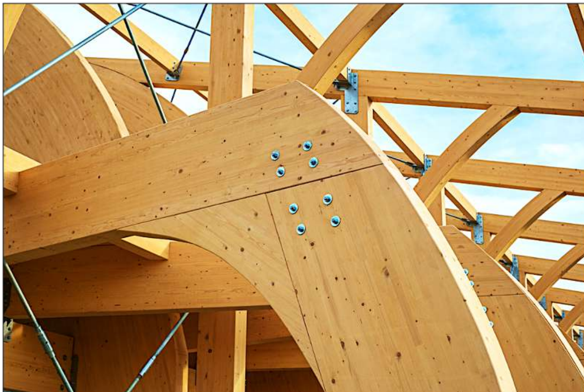
Figura 7 – Madeira Laminada Colada (MLC).
