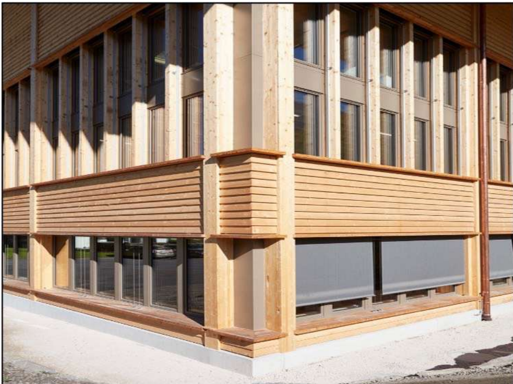
Figura 39 – Elementos da fachada da Fábrica.
