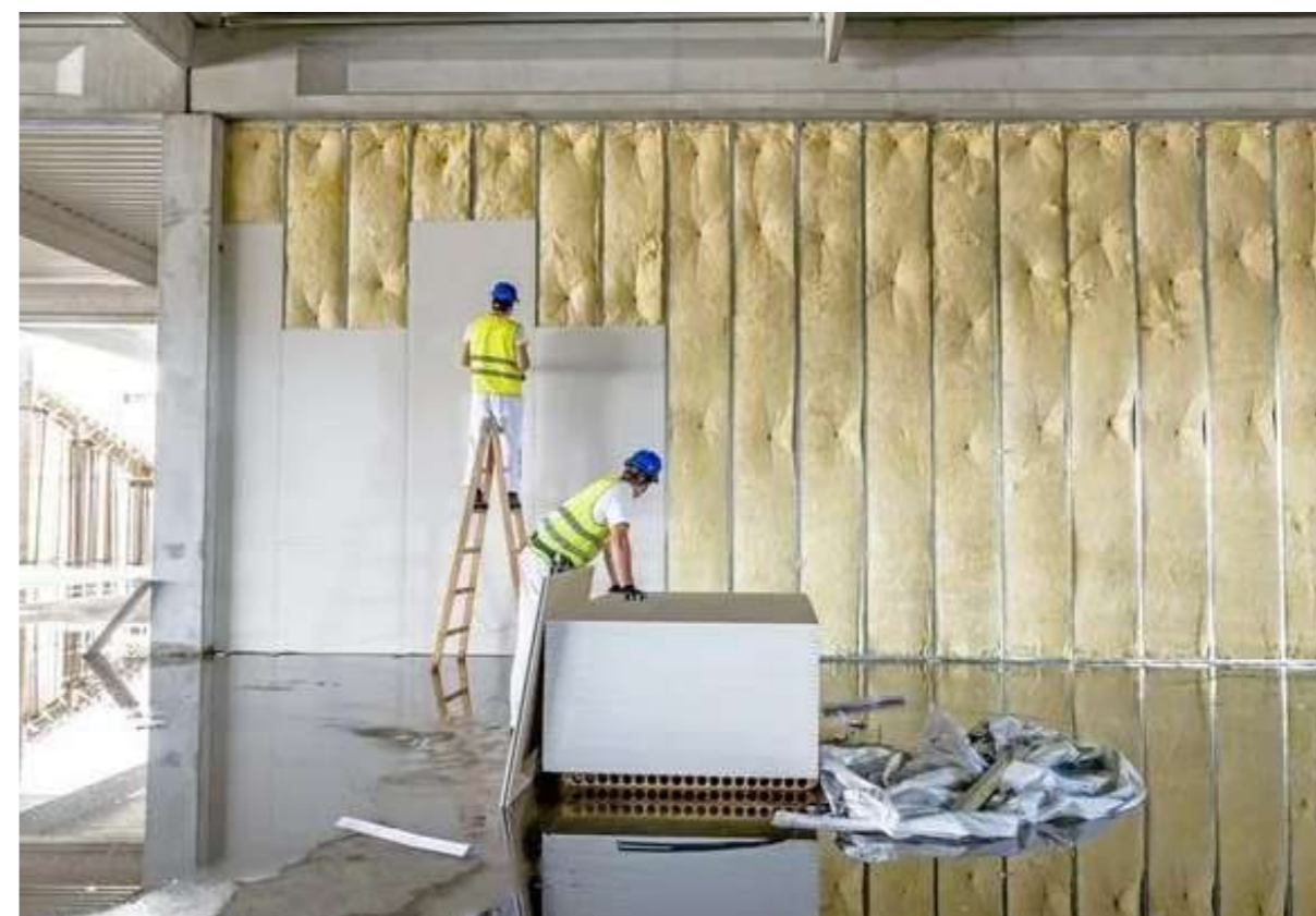
Figura 8 - Aplicação de lã de vidro
