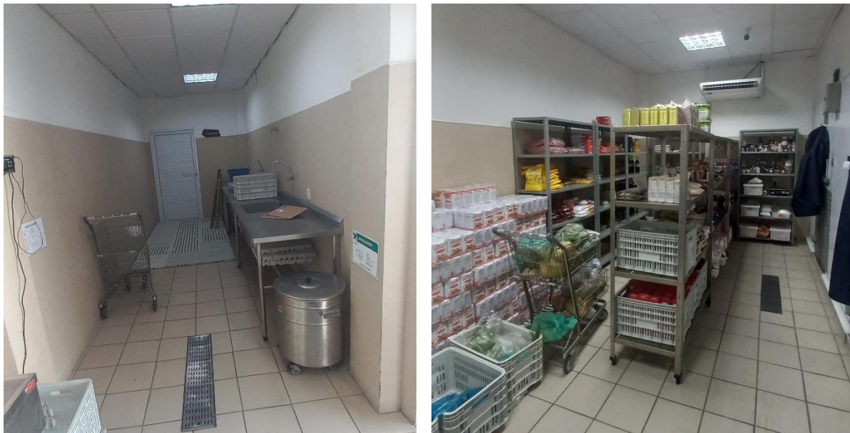
Figura 41 - Setor de Higienização e Despensa, respectivamente
