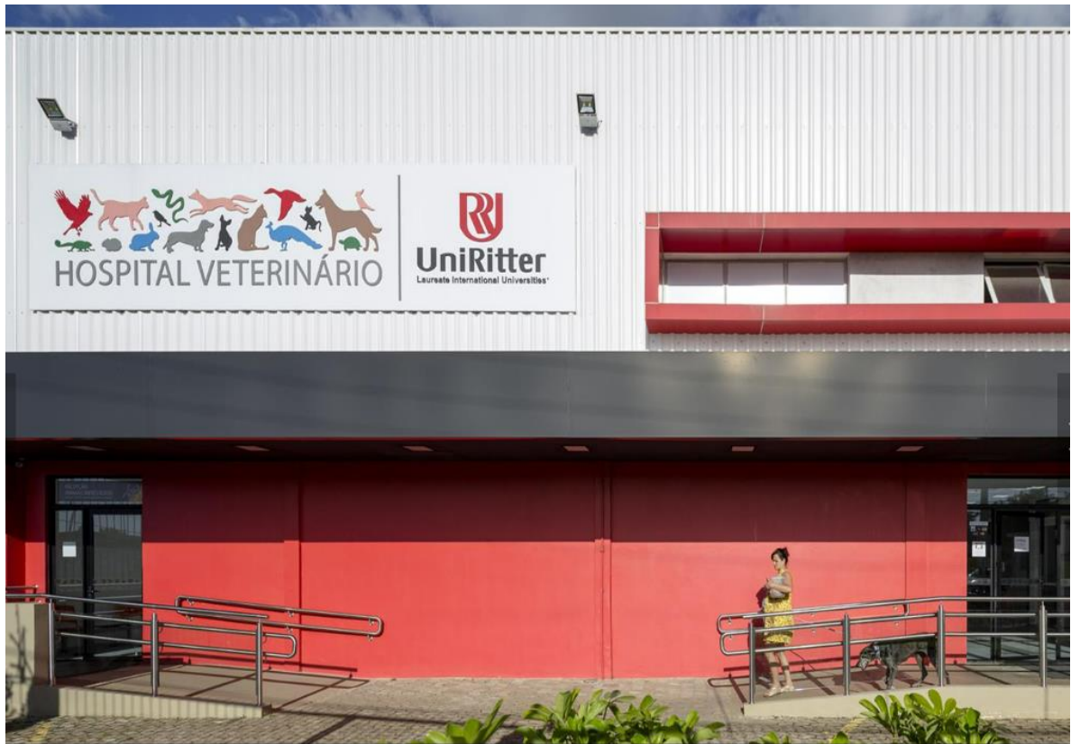
Figura 36 – Fachada Hospital Veterinário UniRitter
