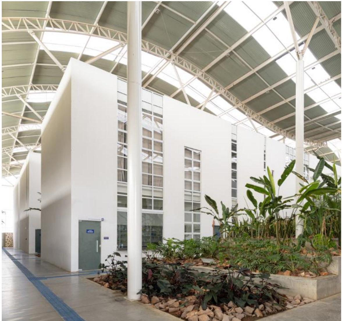
Figura 22 - Edifícios internos do Hospital Veterinário Escola da Unileão
