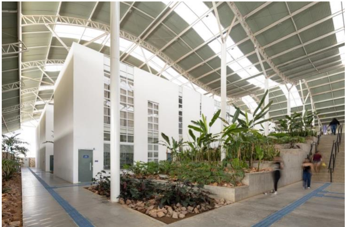
Figura 17 - Soluções para as mudanças de nível no Hospital Veterinário Escola da Unileão
