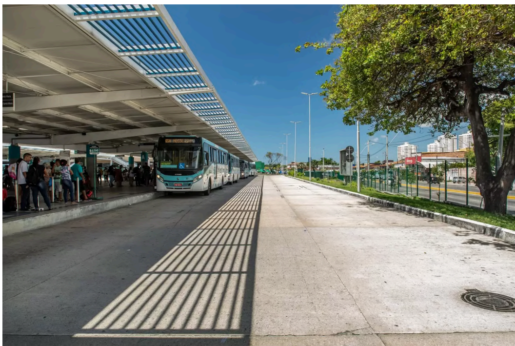
Figura 19 - Plataforma do Terminal da Messejana após a intervenção
