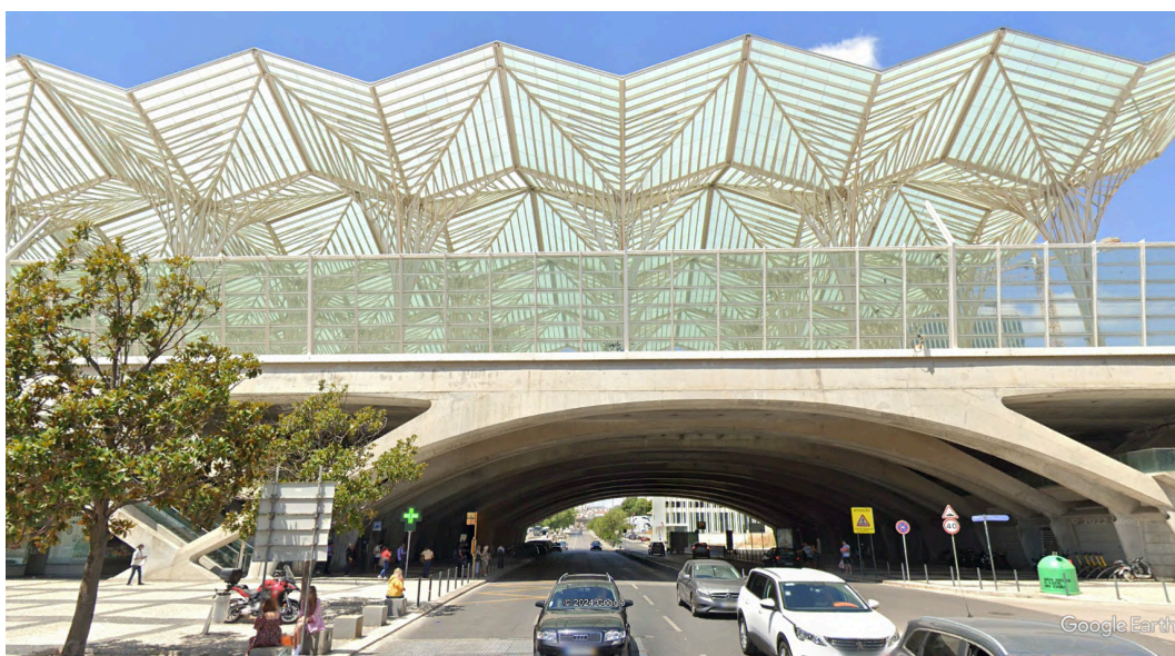
Figura 32 - Túnel em Gare do Oriente.
