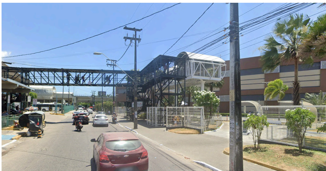
Figura 49 - Passarela na Rua Carlos Amora.
