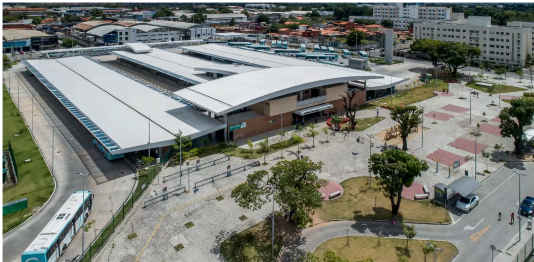
Figura 17 - Terminal da Messejana após a intervenção
