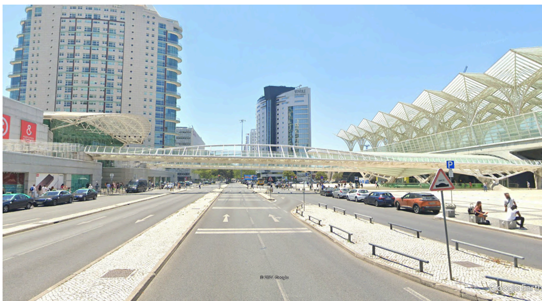
Figura 31 - Passarelas da Gare do Oriente.
