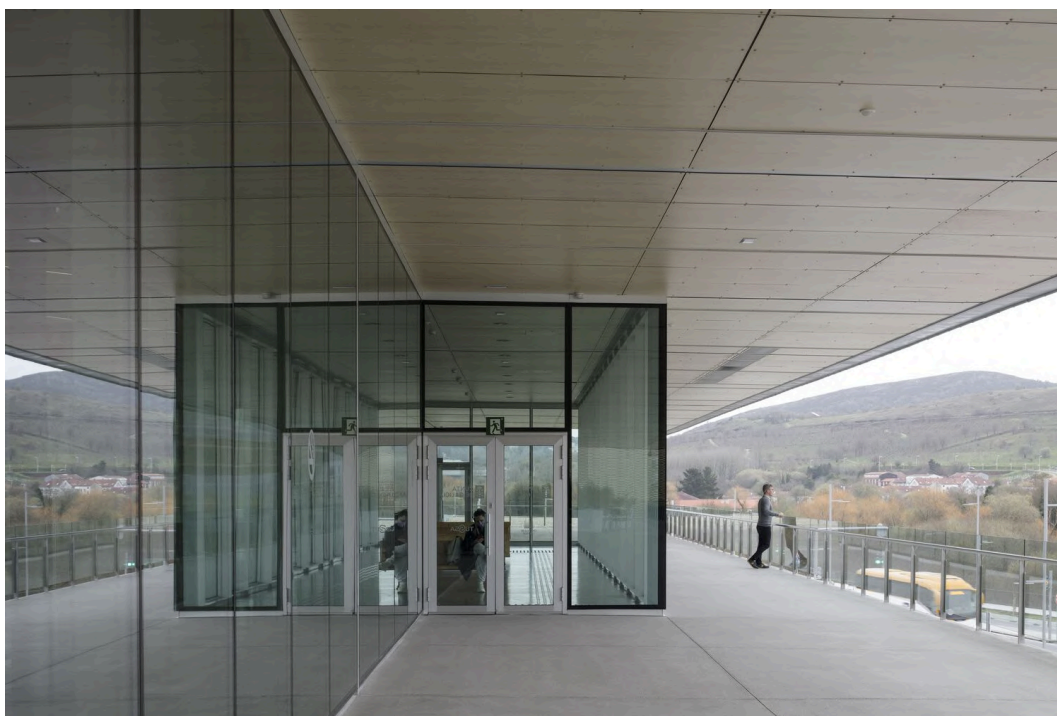
Figura 21 - Foto do pavimento superior.
