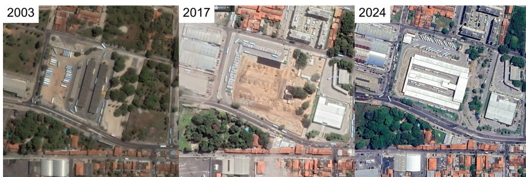
Figura 13 - Evolução do terminal da Messejana. Antes da intervenção (2003), plataformas provisórias durante a intervenção (2017) e após a intervenção (2024).
