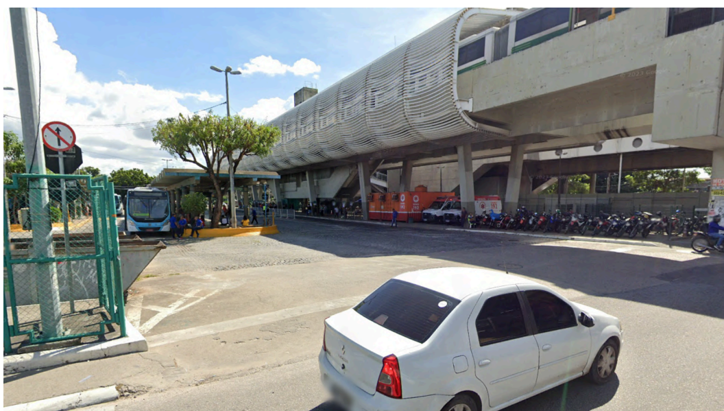
Figura 48- Trecho de acesso de ônibus no terminal da Parangaba.
